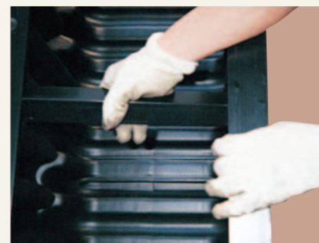
④突きあてアンクルの取付け (下から斜に上げて取付けてください)
