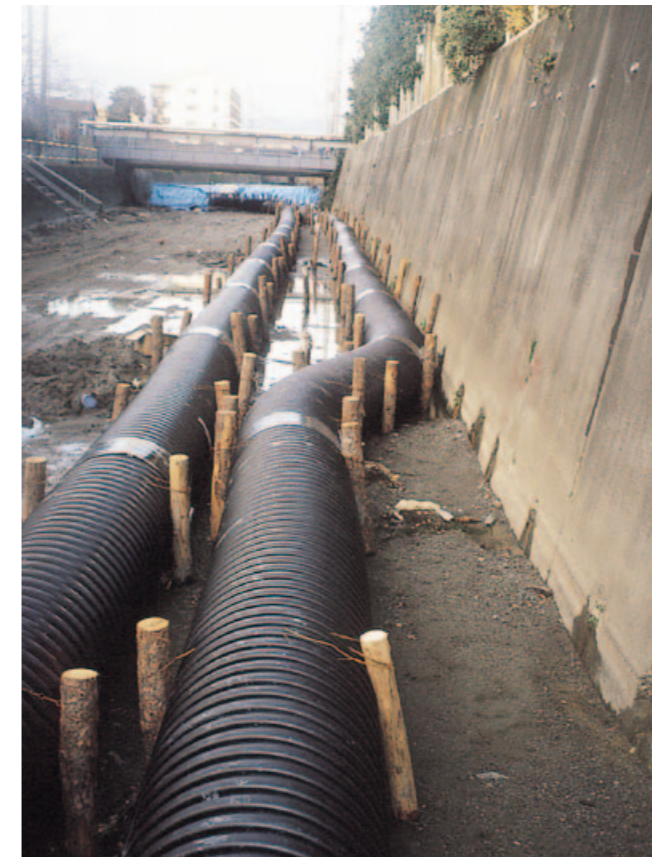
▲河川改修 (水路切り回し) 工事
