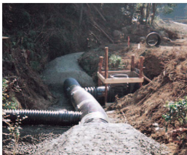
▲土捨場防災暗渠工事
