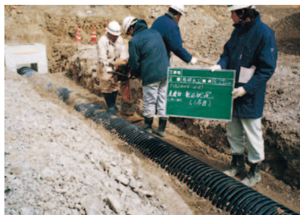
▲NEXCO用排水管工事
