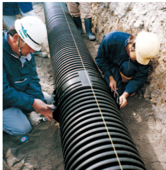
▲リング管ソケットの取付け
