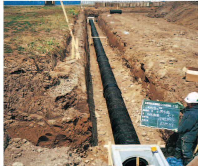
▲ 小排水路の管路化工事
