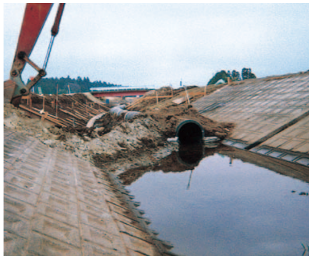
▲河川改修仮排水工事
