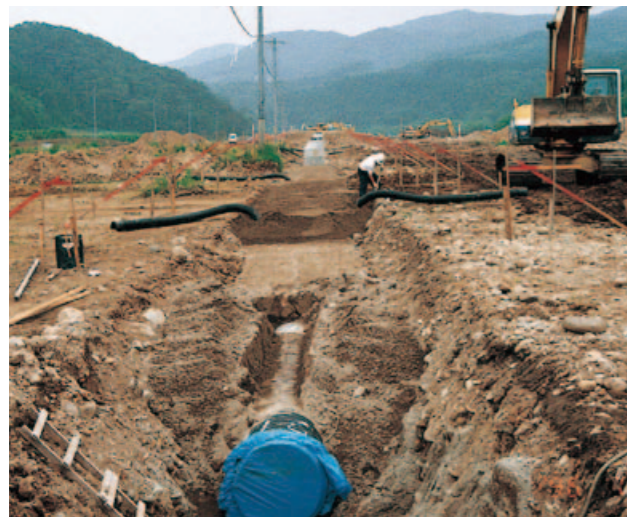
▲圃場整備小排水路管路化工事
