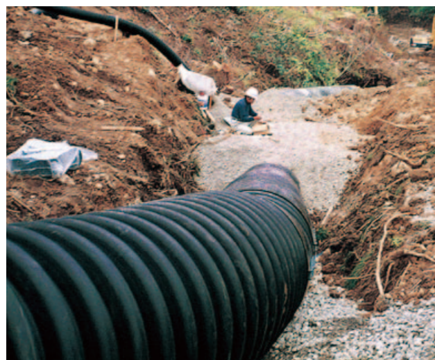
▲土地造成防災暗渠排水工事
