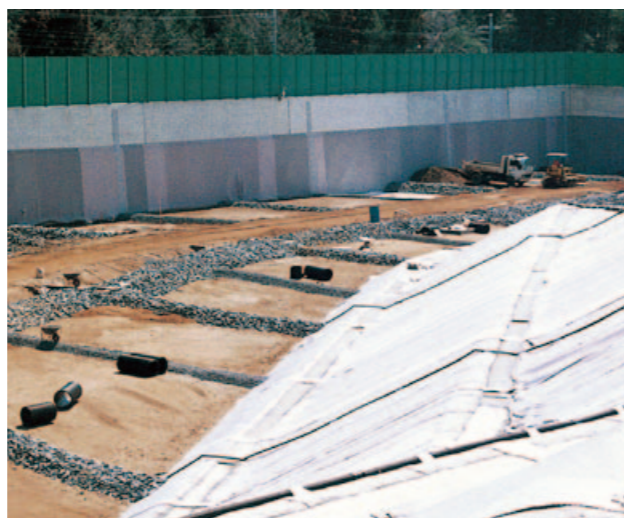
▲一般廃棄物処理場浸出集排水・ガス抜き管工事
