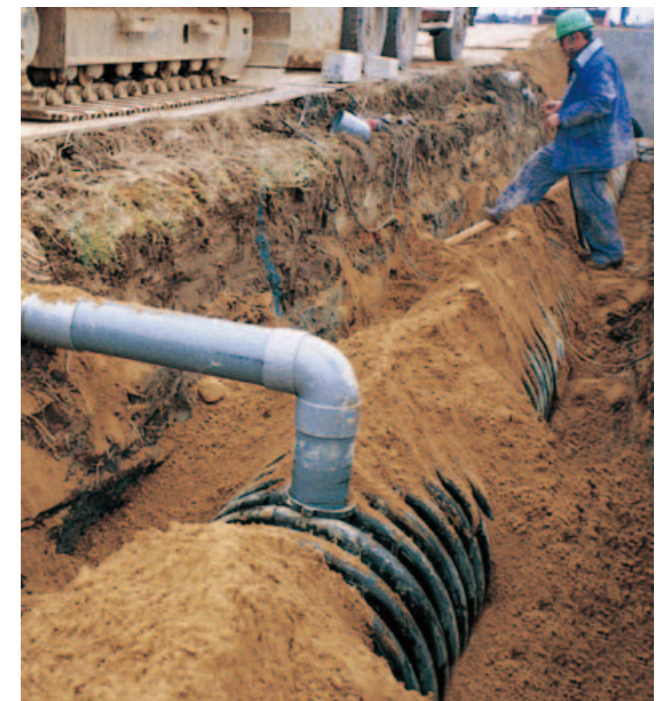
▲ 小排水路の管路化工事、枝管にVU管使用
