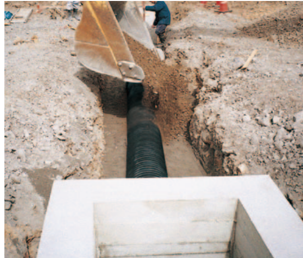
▲ NEXCO用排水管工事
