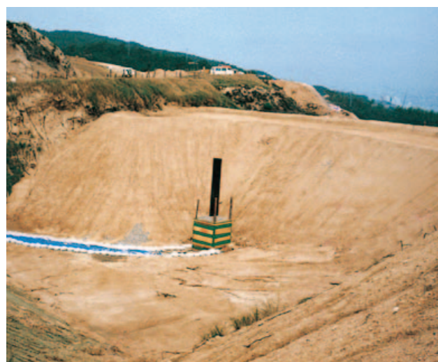
▲土地造成堅形集排水管工事
