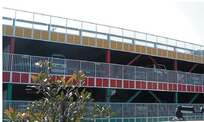
立体駐車場のスラブコンクリート
