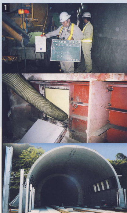
1 鉄道運輸整備機構・ 九州新幹線妙見トンネル新設工事／ 二次覆工はく落防止対策
