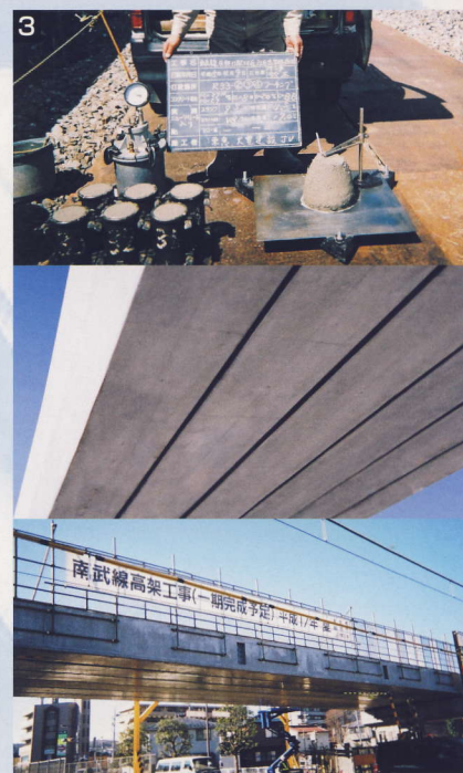
3 東日本旅客鉄道株式会社・ JR南武線稲城長沼付近高架化工事／ はく落防止対策 ※「ニュークリート」はJR東日本の認定品です。
