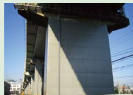
新幹線橋脚の耐震補強
