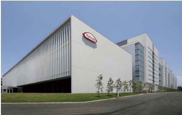
研究施設 スラブコンクリート
