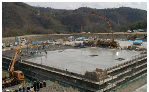
浄水施設 躯体コンクリート
