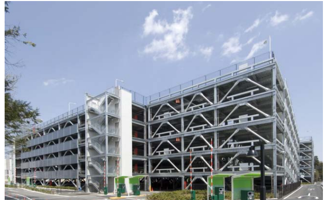
立体駐車場 スラブコンクリート
