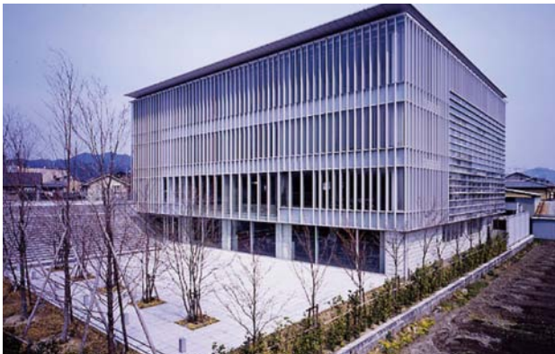
大学校舎 建築躯体コンクリート
