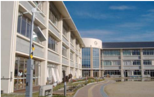
小学校校舎 建築躯体コンクリート
