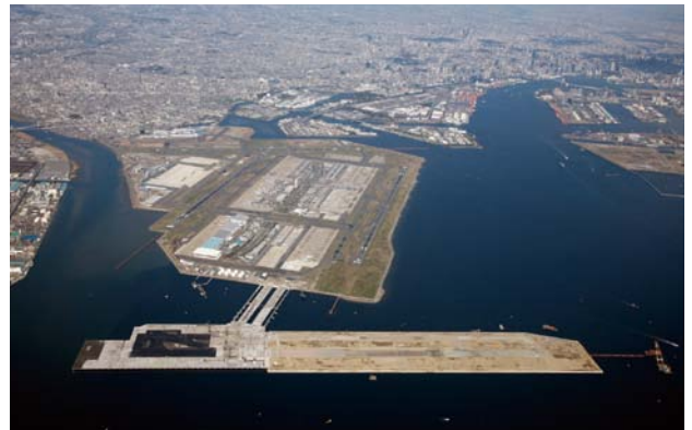
羽田空港拡張工事D滑走路 床版間詰めコンクリート
