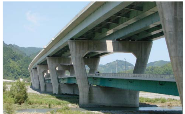
第二東名高速道路 安倍川橋 床版コンクリート
