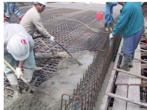
高所でのハイパーエクспанコンクリートの打設状況
