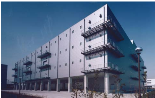
物流倉庫 スラブコンクリート
