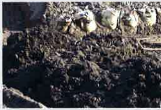
浚渫土の改良前の状況
