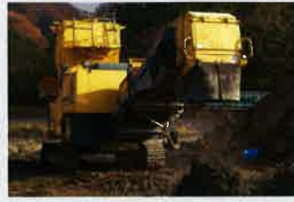
土質改良機にて浚渫泥土を混合中
