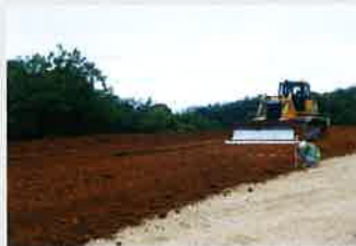
道路の路床盛土に再利用
