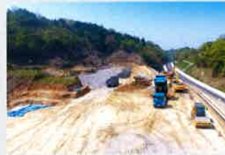
大規模造成工事
