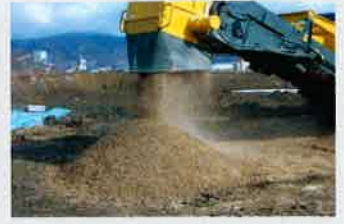
浚渫土の改良直後の状態
