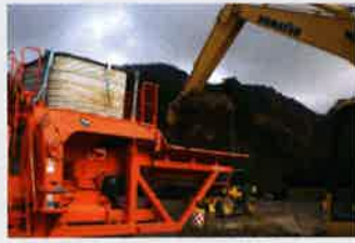
土質改良機に浚渫泥土を投入
