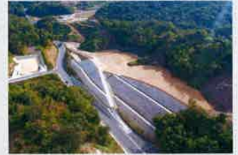
法面・砂防工事で 再利用後に緑化した実施例
