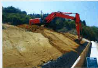
道路の路体盛土に再利用
