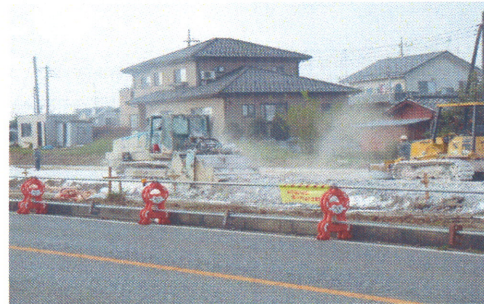
生石灰粉状品による施工状況
