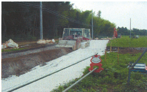
ドライムソフトによる施工状況
