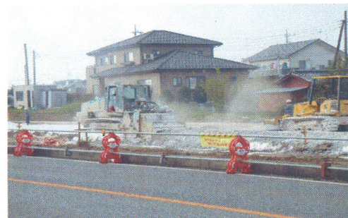
生石灰粉状品による施工状況
