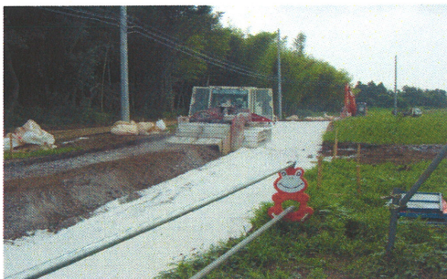
ドライムソフトによる施工状況
