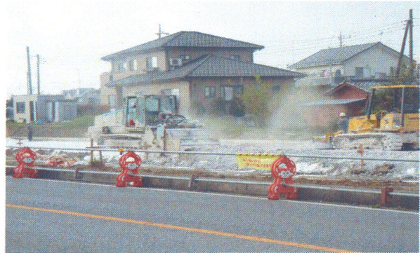
生石灰粉状品による施工状況
