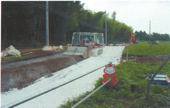
ドライムソフトによる施工状況
