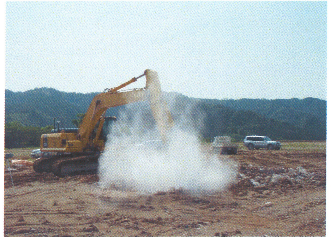
生石灰粉状品 (一般品)による混合状況
