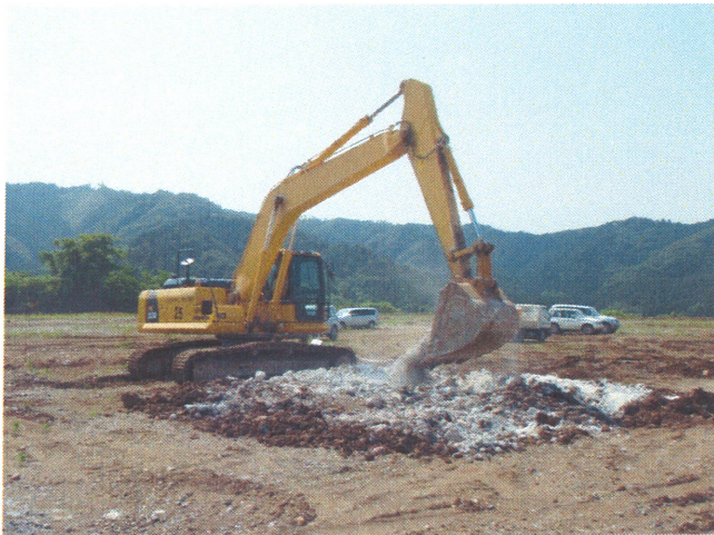
ドライムソフト による混合状況
