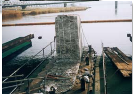
橋脚破碎 (ビット径50mm)
