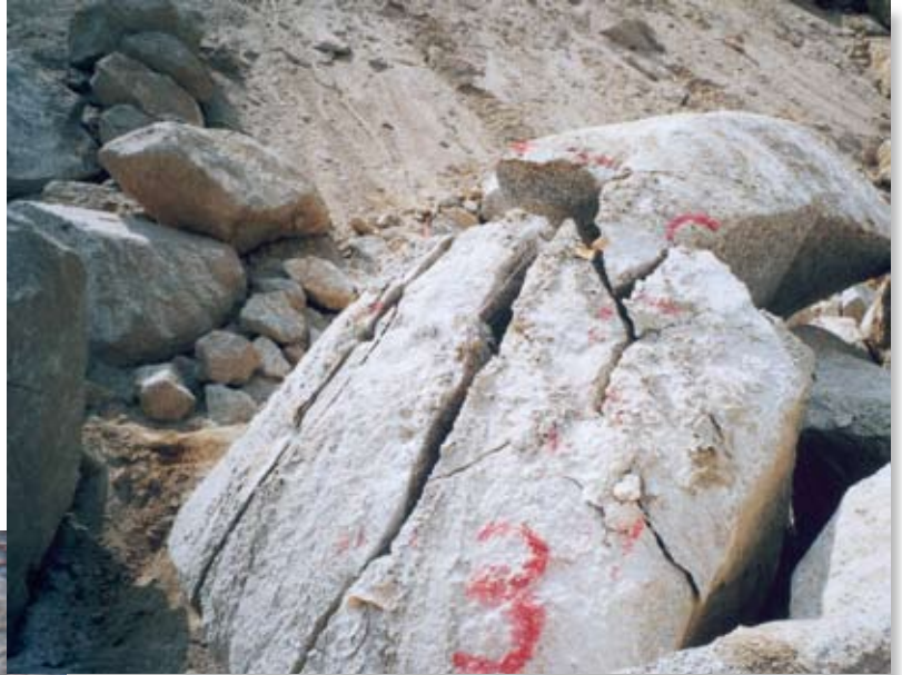
転石の破碎(ビット径42mm)
