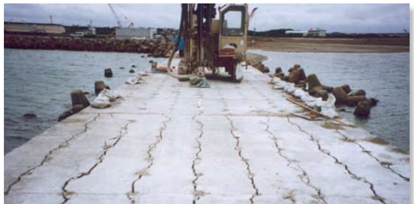
防波堤破碎(ビット径65mm 孔間隔650mm)
