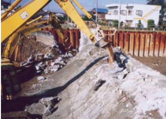
固定堰破碎 (ビット径65mm)
