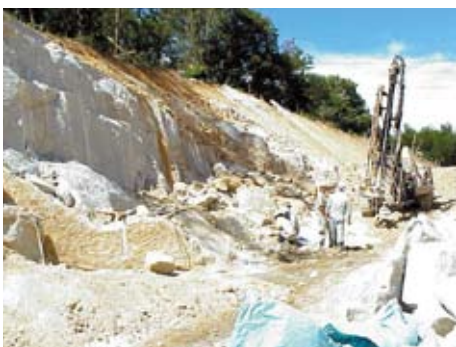
岩盤ベンチカット破碎(ビット径65mm)
