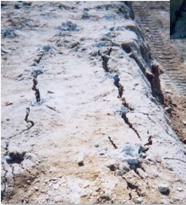
岩盤ベンチカット破碎(ビット径65mm)
