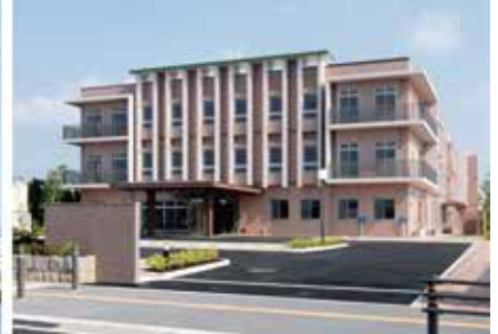
アイランドシティ照葉 (基礎地中梁・ピット躯体)
