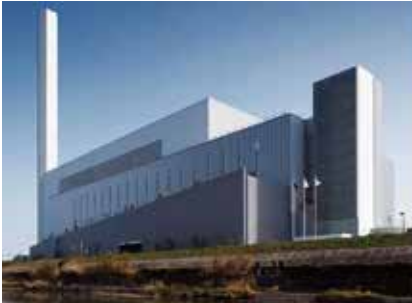
東淀清掃工場 (地下躯体)
