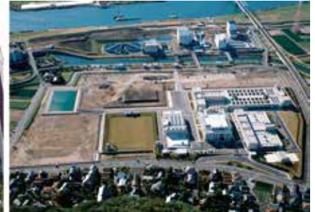
ちば野菊の里浄水場 (排水池・水槽ほか)
