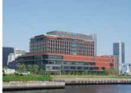
昭和大学江東豊洲病院 (免震ピット)
