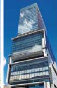
渋谷ヒカリエ (地下躯体)
