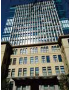
早稲田大学D棟 (政治経済学部) (地下躯体)
