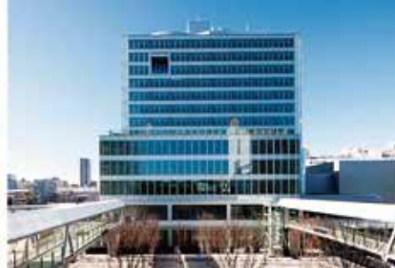
東京電機大学千住キャンパス (地下躯体)
