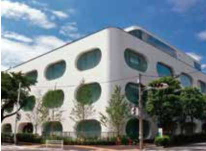
武蔵野プレイス (地下躯体・免震ピット)
