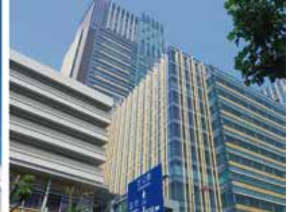
東京ミッドタウン (地下室・躯体)
